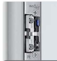
Die neue Tagesfalle Funktion (am Schließblech / Schließleiste)
